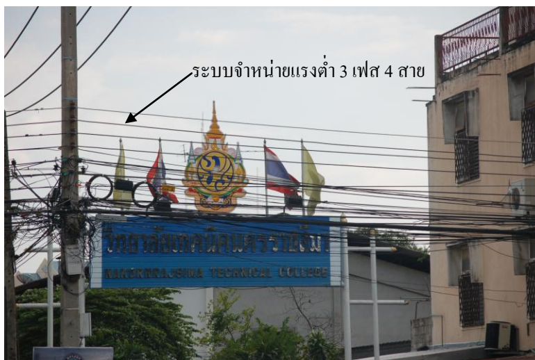
รูปที่ 1.32 แสดงระบบจำหน่ายแรงต่ำ 3 เฟส 4 สาย แรงดัน 400/230 V อำเภอเมืองนครราชสีมา จังหวัดนครราชสีมา (ที่มา:ทวี ไชยโคตร,2553)
